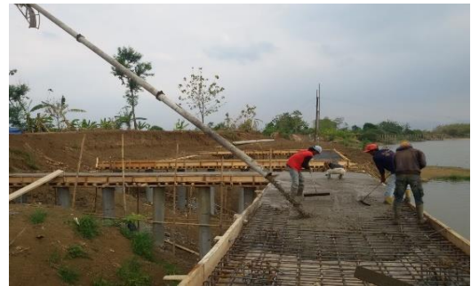
Gambar 9. Pengecoran
