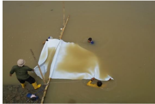
Gambar 11. Pemasangan Geotextile
