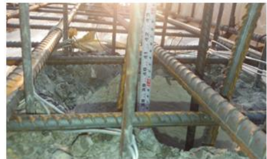
Gambar 7. Pengukuran angkur pancang
