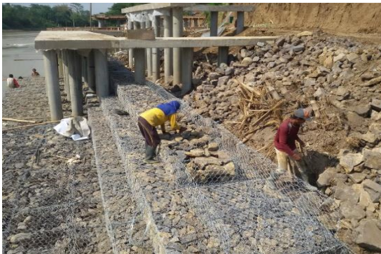
Gambar 14. Pemasangan batu bronjong
