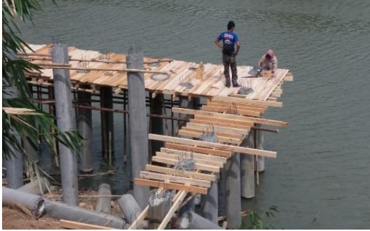
Gambar 4. Bekisting
