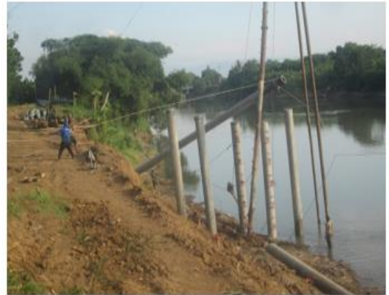
Gambar 1. Pengangkatan Pancang
