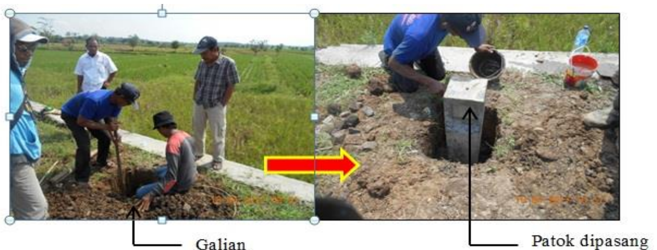
Gambar-5 Pemasangan patok
