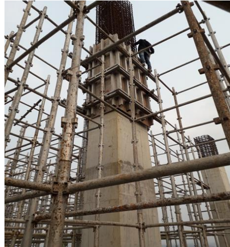
Gambar 4. pemasangan bekisting kolom
