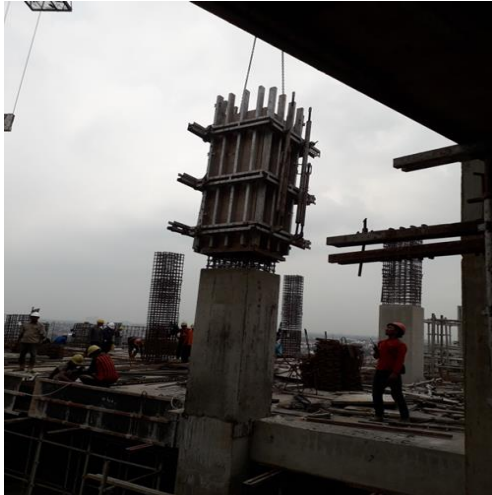
Gambar 5 pembukaan bekisting kolom
