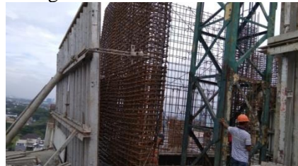
Gambar 4. Proses Pemasangan Bekisting
