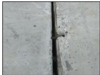
Gambar 15. Pemasangan dowel
