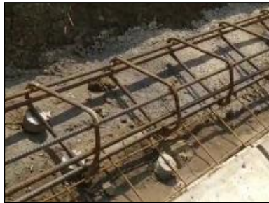
Gambar 21. Pembesian capping beam
