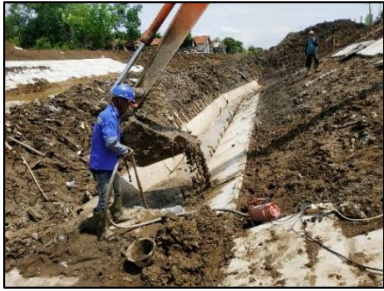
Gambar 16. Pengecoran subgrade
