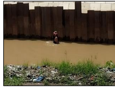
Gambar 26. Proses menutup kebocoran
