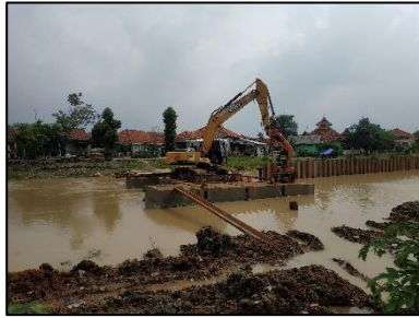
Gambar 7. Pekerjaan pemancangan SSP
