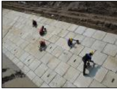
Gambar 24. Pekerjaan join sealent/filler
