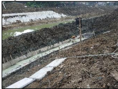
Gambar 12. Pemasangan bowplank
