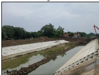
Gambar 25. Struktur lining telah dikerjakan
