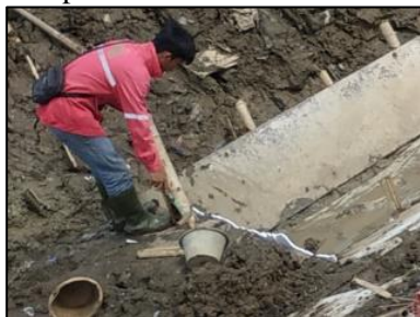
Gambar 13. Pemasangan bekisting subgrade
