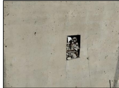
Gambar 19. Pekerjaan weep hole
