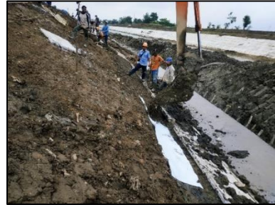
Gambar 18. Pemasangan baris ke-3 & ke-5
