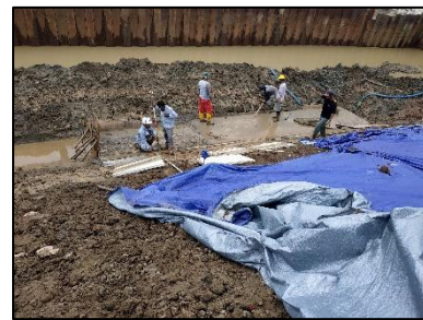
Gambar 27. Dewatering pada genangan air
