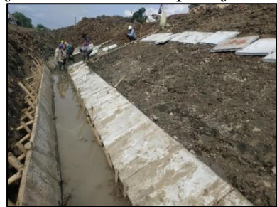
Gambar 14. Pemasangan block lining baris ke-1
